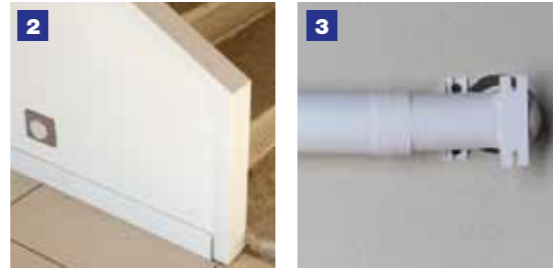
Sous un escalier
