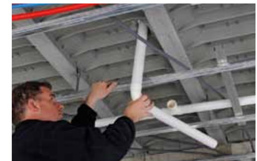
Traversée de dalle (R vers R+1)
