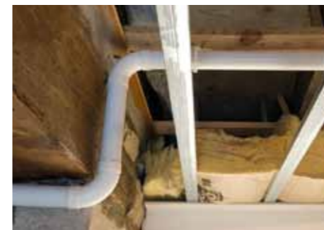
Passage poutre en apparent puis passage faux plafond
