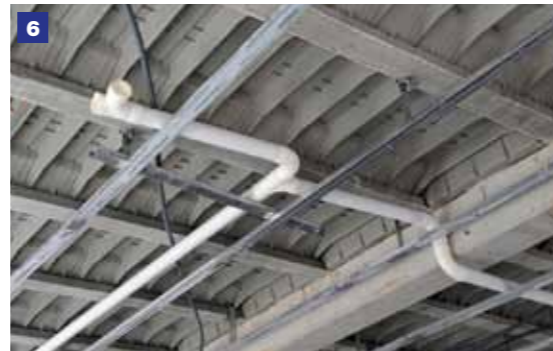
Montage en faux plafond
