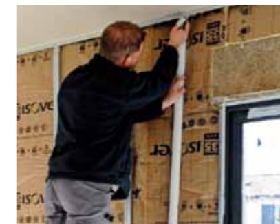
Montage en doublage
