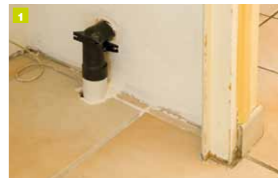
Remontée en placard
